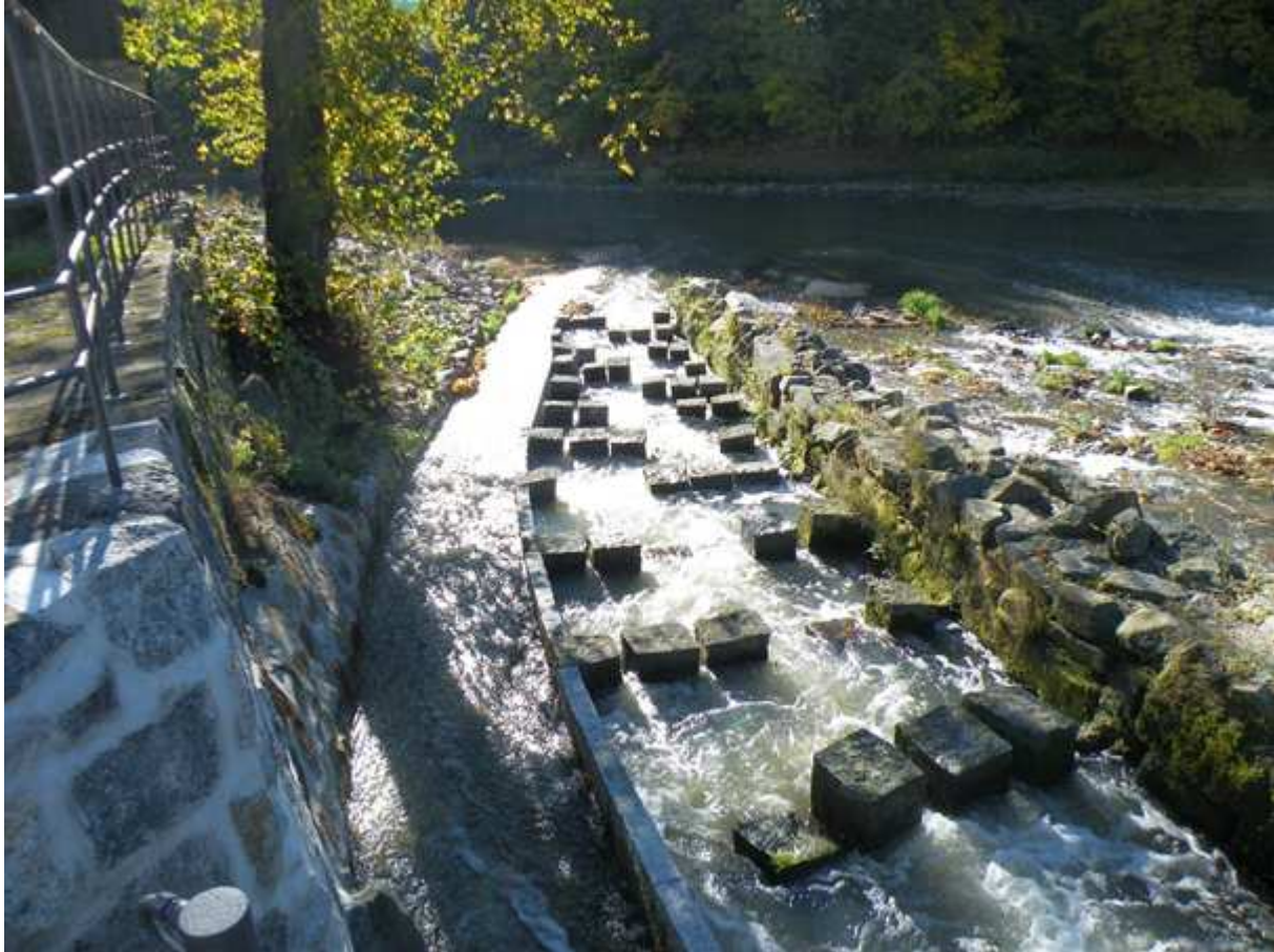
Abb. 1: Fischaufstieg der Wasserkraftanlage des Klosterstifts St. Marienthal, Ostritz (Sachsen), deren Reaktivierung von der Deutschen Bundesstiftung Umwelt (DBU) gefördert wurde; Quelle: T. Fechner
